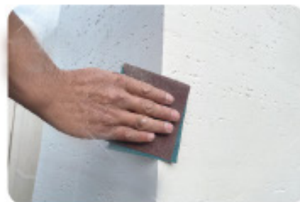
6 Lijar la esquina con papel abrasivo para suavizar los bordes.
