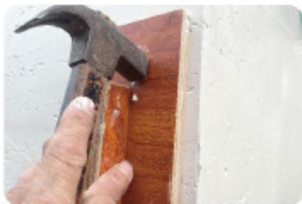
4 Una vez colocado el producto, aplicar presión con una placa para rellenar la junta a 45°.
