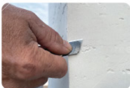
7 Recortar los bordes con un cúter o bisturí.
